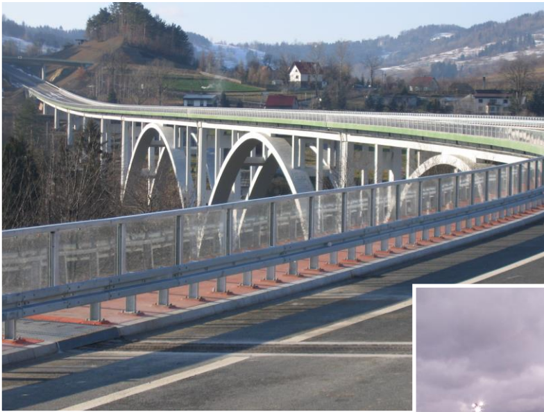
Fotografie - archiwum Cementowni Warta S.A.
