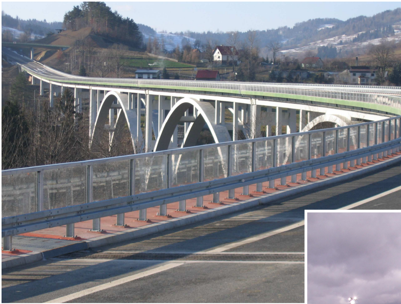
Fotografie - archiwum Cementowni Warta S.A.
