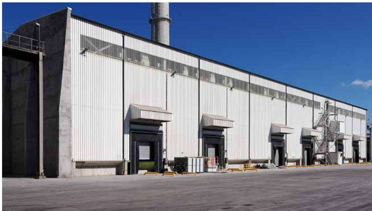
Fot. Błażej Boryń, Hala paliw alternatywnych
