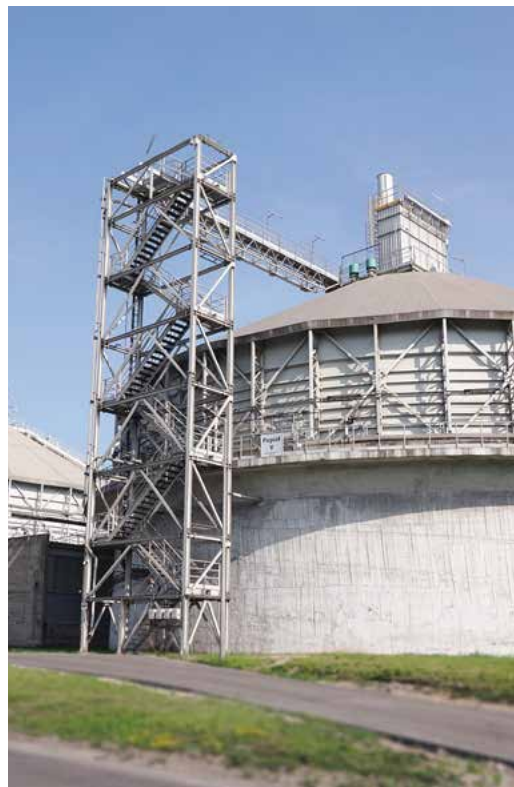
Fot. Błażej Boryń, Zbiornik magazynowy popiołu
