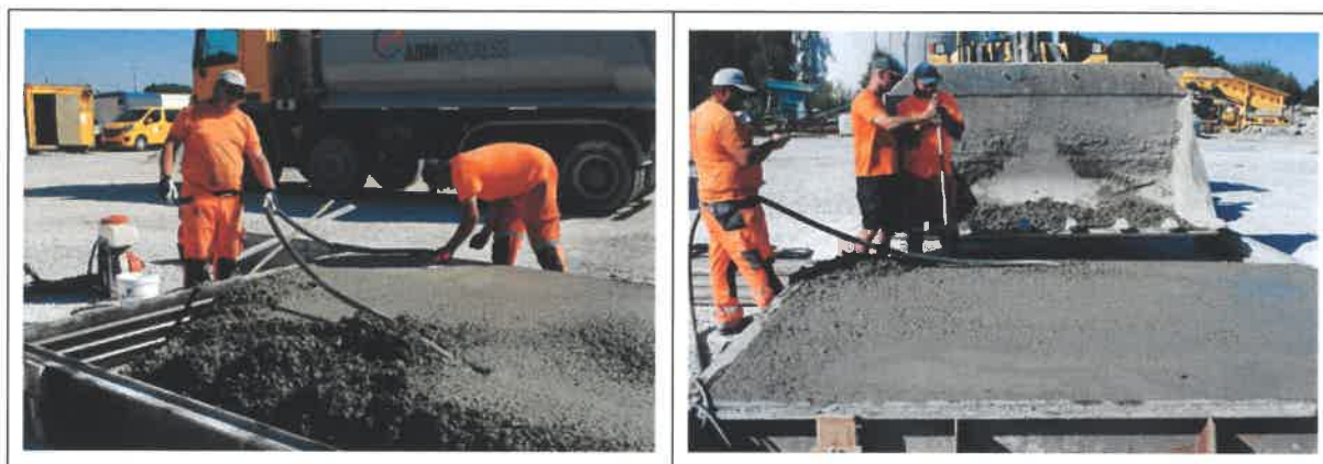
Rys. 3.2.1-1. Wykonywanie odcinka doświadczalnego z betonu z cementem CEM I 42,5 N- NA (zagęszczanie mieszanki betonowej)
