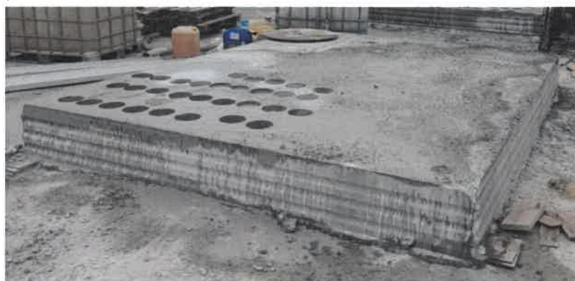
Rys. 3.2.1.-3. Odcinek doświadczalny wykonany z betonu z cementem CEM I 42,5 N-NA po pobraniu odwiertów
