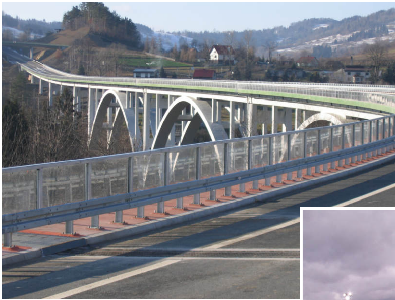
Fotografie - archiwum Cementowni Warta S.A.
