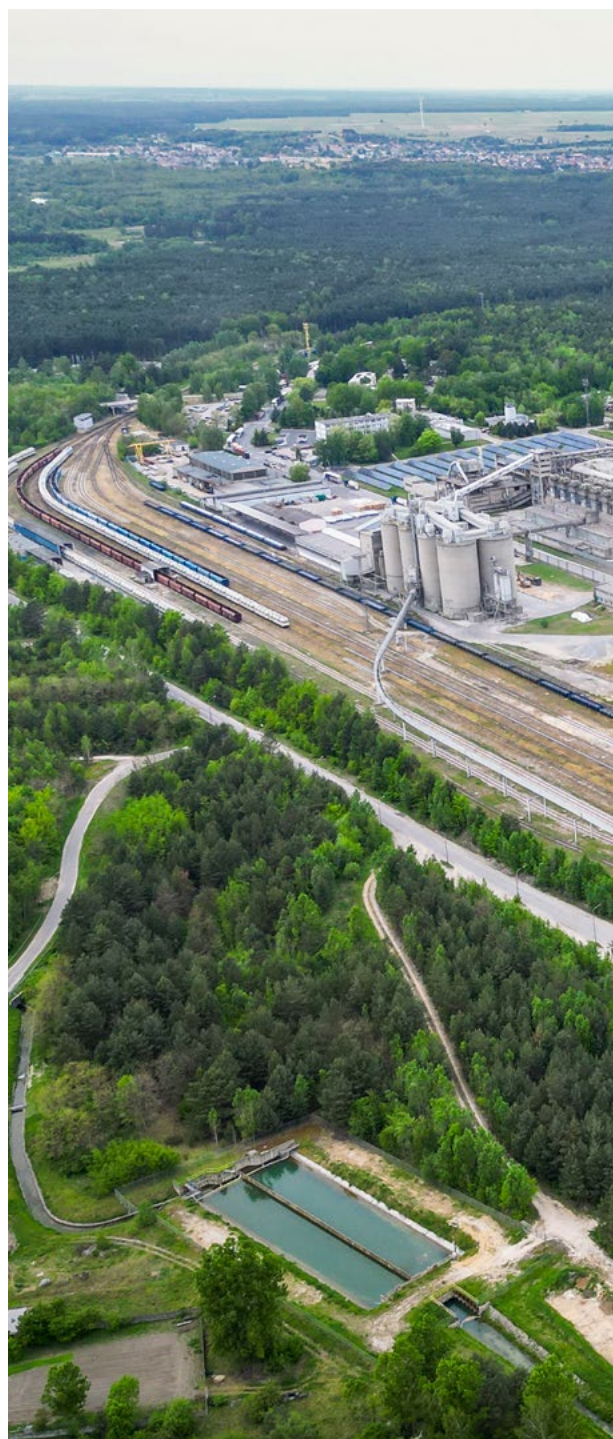
Fot. Michał Braszczyński, Cementownia Warta S.A.
