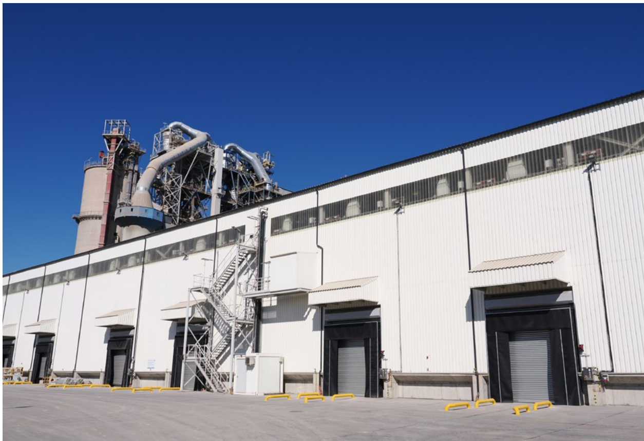
Fot. Błażej Boryń, Hala paliw alternatywnych
