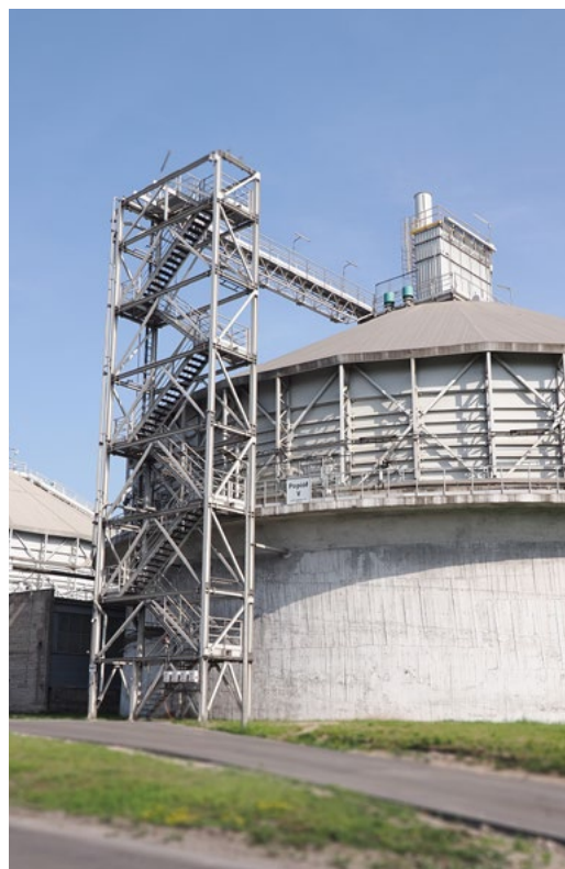
Fot. Błażej Boryń, Zbiornik magazynowy popiołu
